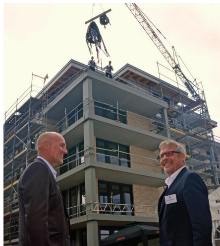
Kai Boysen (li.) und Werner Eissing , die Initiatoren der „Alten Gärtnerei“, freuen sich über den Richtspruch des 2. Bauabschnitts. RF
